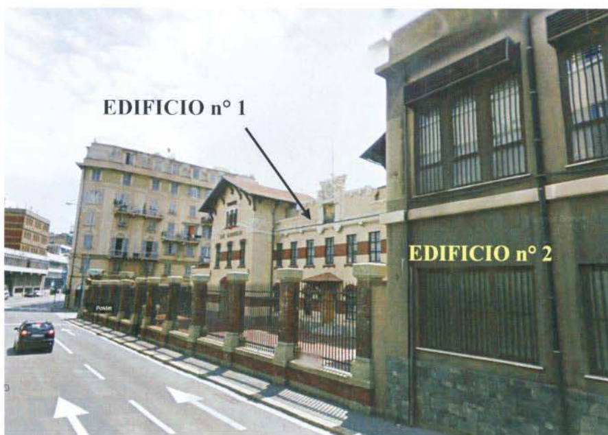
• - VISTA DEI FABBRICATI DA PONENTE -
